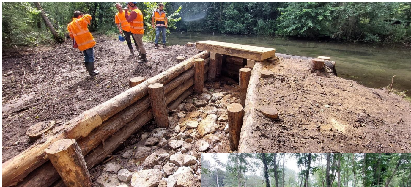
Les travaux sur Cailles et Boigny (Le Mérévillois / Saclas) ont consisté à fixer une brèche et à restaurer les berges du bief, de manière à opérer une répartition de débit entre le lit perché (40%) et le cours
