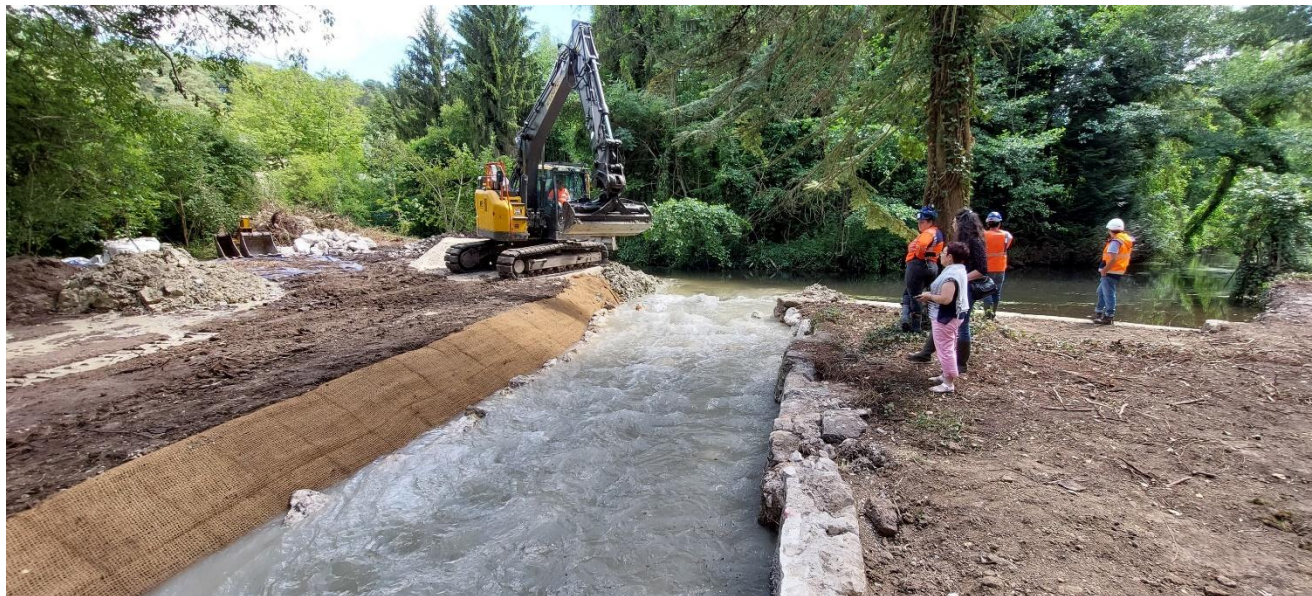
Les travaux sur le bief St Denis (Saclas) ont consisté à court-circuiter les ouvrages du moulin en créant une connexion vers le lit naturel par une rampe
