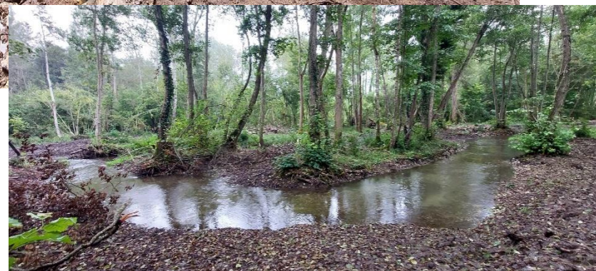
Les travaux sur Cailles et Boigny (Le Mérévillois / Saclas) ont consisté à fixer une brèche et à restaurer les berges du bief, de manière à opérer une répartition de débit entre le lit perché (40%) et le cours
