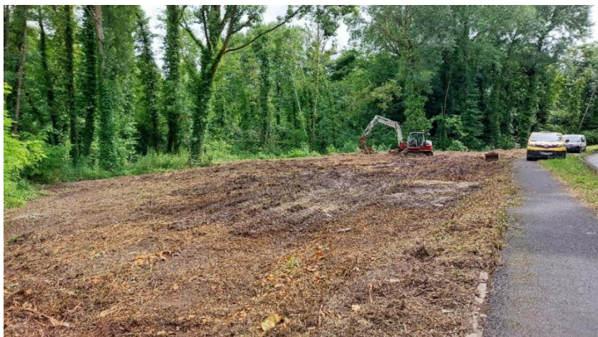
Sondage de terrain pour évaluer les opérations de retrait de remblais en zone humide (Auvers-Saint-Georges)
