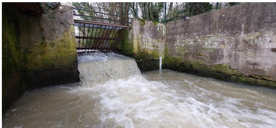
Plusieurs équipements métrologiques ont été installés sur les cours d'eau du bassin versant. Ici, un point de mesure hauteur/Débit sur le ruisseau du Mauvais temps à Saint-Vrain
