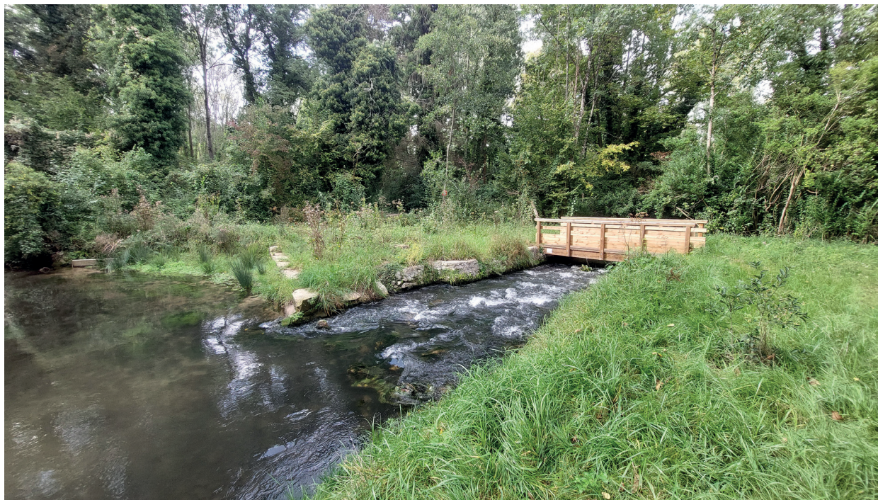
Les travaux sur le bief St Denis (Juine à Saclas) ont consisté à court-circuiter les ouvrages du moulin en créant une connexion vers le lit naturel par une rampe en enrochement.
